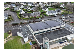
Poher Communauté | Installation PV en autoconsommation totale sur l'espace Aqualudique
